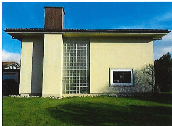
Abb. 11 Pfarrhaus, Westfassade mit Aussenwärmedämmung versehen. Quelle Roger Wyss
