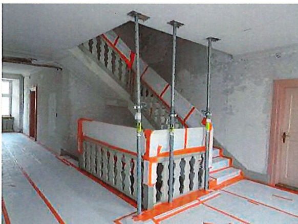
Abb. 15 Während der Sanierungsarbeiten wurden aus Sicherheitsgründen die Geländer auf 1.1 m erhöht. Quelle Roger Wyss
